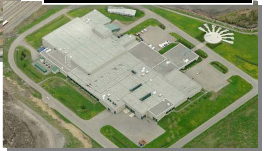
STATION DE TRAITEMENT DES EAUX USÉES EST
