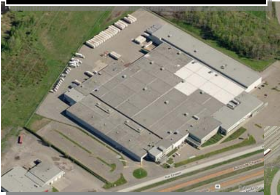
STATION DE TRAITEMENT DES EAUX USÉES OUEST
