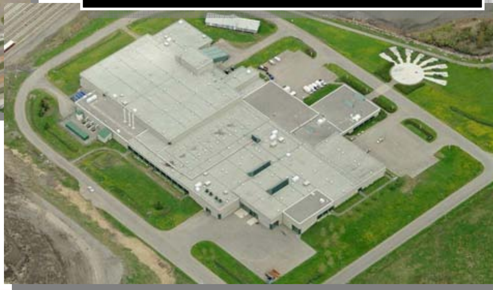
STATION DE TRAITEMENT DES EAUX USÉES EST
